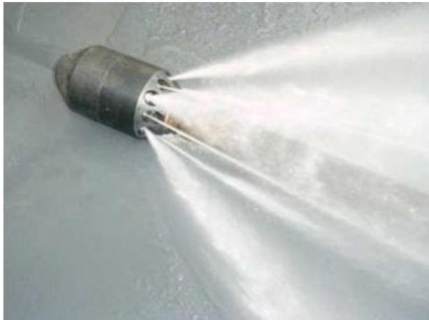
Durch das Wasser, welches mit hohem Druck aus der Düse ausströmt, wird die Abwasserleitung wirkungsvoll gesäubert. Die Düse bewegt sich dabei stets im Bereich des öffentlichen Kanals, niemals im Bereich des privaten Hausanschlusses.
